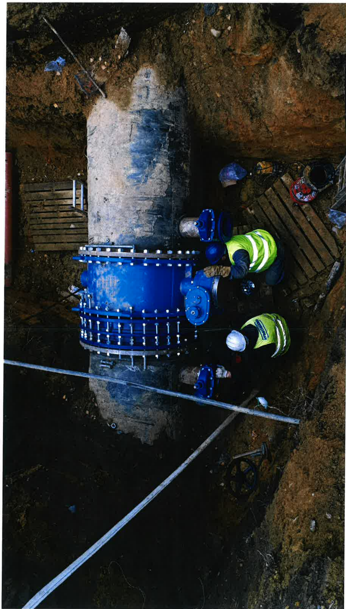
PUNKT C - przepustnica ziemna DN 1200 z dwustronnym zawieszaniem DN 200 w ogrodniku przy bloku Dytkowska 103
